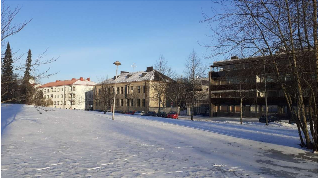
Kuva 2. Ristimäenpuisto ja Ristimäenkatu. Keskellä Graniittitalo.
